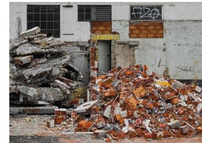
Bau- und Abbruchabfälle
